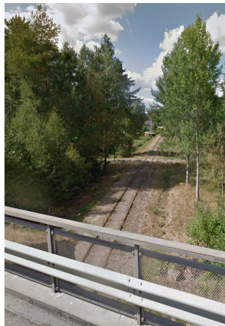
Foto 4 Bandel 872 mot väster vid riksväg 47
