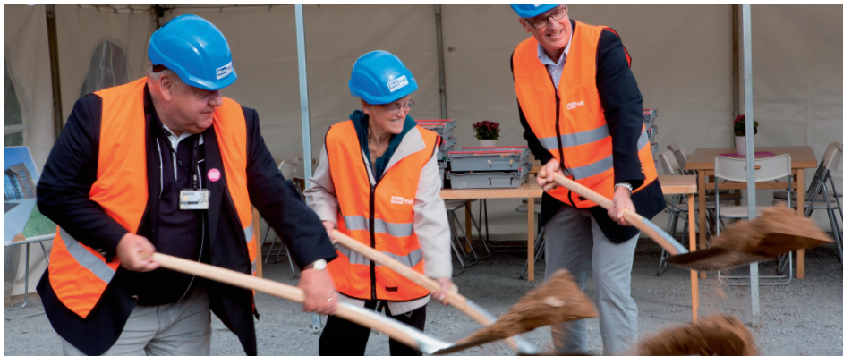
Här tas första spadtaget till hjälpmedelscentralen i Jönköping. FOTO: JOHAN WERNER AVBY
