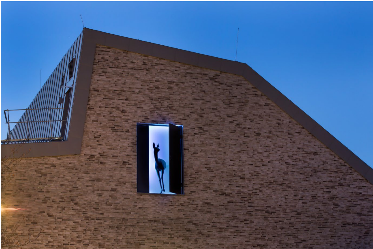
Konstverket Passage av Kultivator i nybyggda Hus D1 vid Länssjukhuset Ryhov.
