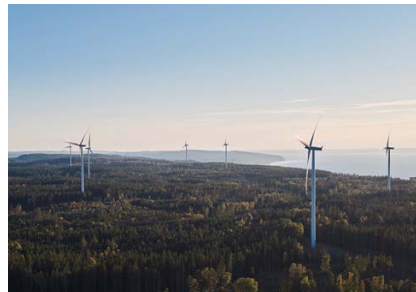
Foto: Destination Jönköping
